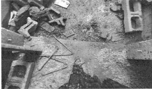
Foto 1: Modulo 2 Bodega, sustitucion de de baño por aula
