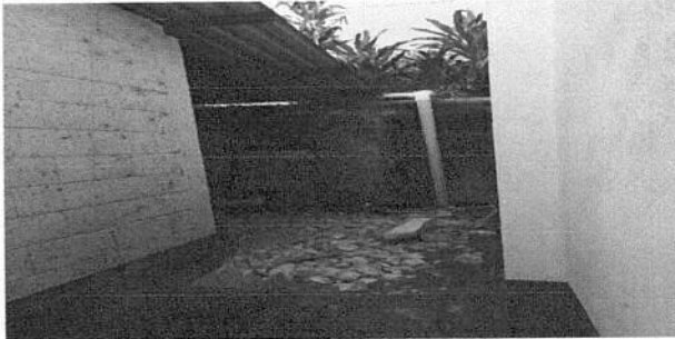
Foto 5: modulo 2 ampliacion de aula,
